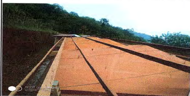
Foto1: SEGUNDA SEMANA DE TRABAJO DE SUSTITUCION DE LAMINAS POR LAMINAS TROQUELADAS
