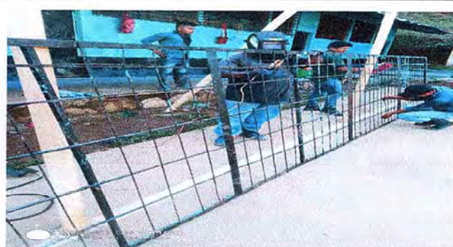
Foto 2: SEGUNDA SEMANA DE TRABAJO DE MANTENIMIENTO DE BALCONES Y VIDRIOS
