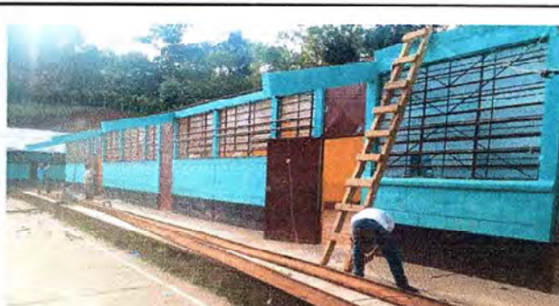
Foto 6: SEGUNDA SEMANA DE TRABAJO DE MANTENIMIENTO DE PUERTAS
