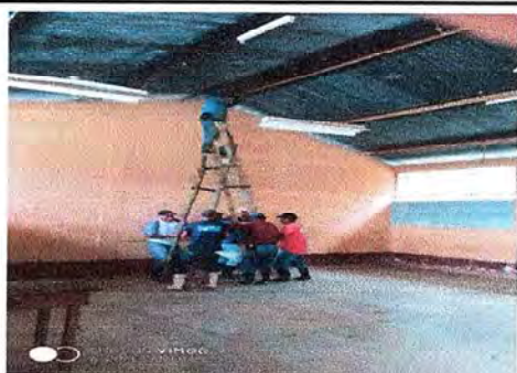
Foto 5: SEGUNDA SEMANA DE TRABAJO DE INSTALACION ELECTRICA
