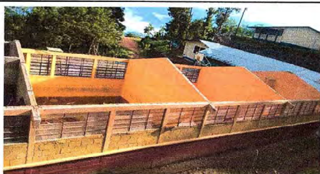
Foto 3: SEGUNDA SEMANA DE TRABAJO DE PINTURA DE INTERIOR Y EXTERIOR
