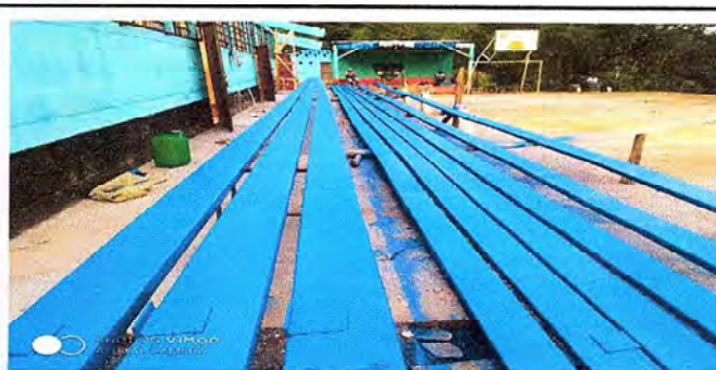
Foto 4: SEGUNDA SEMANA DE TRABAJO DE MANTENIMIENTO DE ESTRUCTURAS
